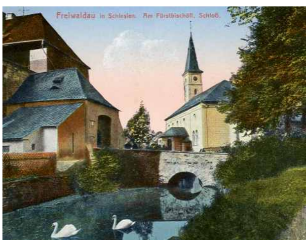
Vodní příkop u Vodní tvrze je už bohužel minulostí, voda se ztratila v 60. letech 20. století, jedním z důvodů byly stavební úpravy v jejím blízkém okolí. Reprofoto: SOka Jeseník
