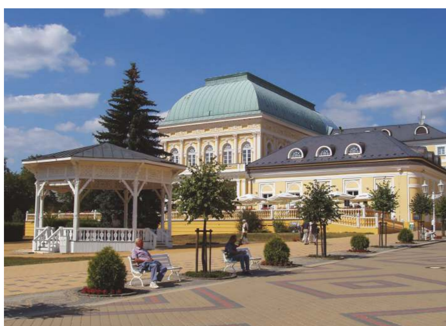
Společenský dům je nejstarší veřejnou budovou Františkových Lázní. Architektonický skvost byl postaven v roce 1795 podle plánů Gustava Wiedermanna. Foto: FOIBOS BOOKS
