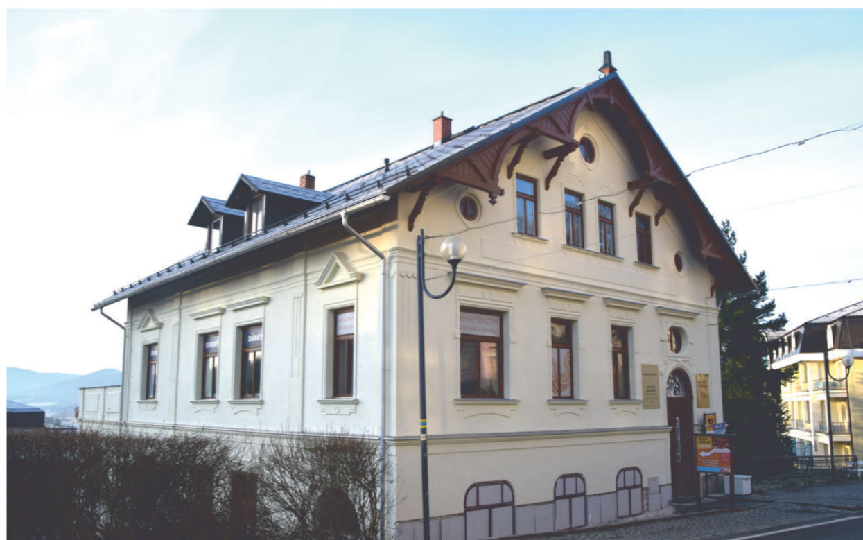
Lázeňský dům Douche po rekonstrukci na konci roku 2023
